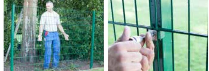
Sind die Zaunelemente befestigt, sollte das Gesamtbild der Zaunanlage nochmal auf Ausrichtung und Stand überprüft werden. Kleine Korrekturen lassen sich jetzt noch ausführen. Zwischen Boden und Zaunelement sollte der gewünschte, dem Gelände angepasste Abstand, vorhanden sein.
