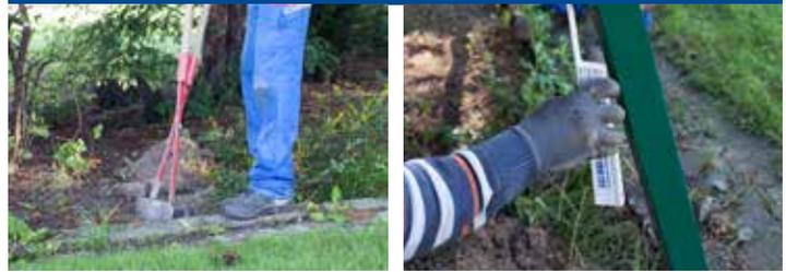
Die Pfostenlöcher in einer Tiefe von 60 bis 70 cm und 30 bis 60 cm Ø ausheben, je nach Bodenbeschaffenheit. Den ersten Pfosten in das Loch stellen, Estrichbeton mit Wasser erdfeucht anmischen. Beton durch feststampfen verdichten. Den Pfosten entsprechend der Flucht und der Waage ausrichten.
