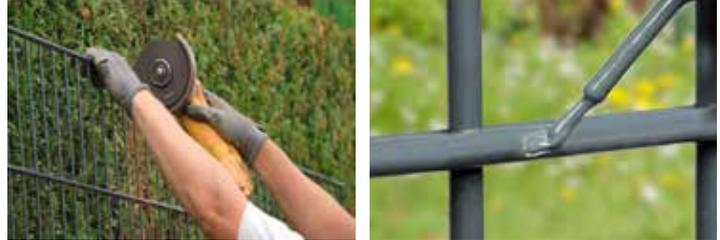
Um Zaunelemente auf eine abweichende Länge zu kürzen, benutzen Sie einen Bolzenschneider oder einen Winkelschleifer (vom Funkenflug der Pulverbeschichtung fernhalten!). Der Schnitt sollte nur neben einem Knotenpunkt des Senkrechtstabes erfolgen. Schnittflächen versiegeln. (s. Zubehör)
