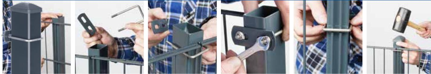
Zunächst werden die Zaunelemente weitgehend gerade am Pfosten ausgerichtet - hierzu können die Elemente entsprechend mit Holz unterbaut werden. Dann wird der U-Bügel vorne auf den Pfosten gesteckt und hinten mit der Platte und
