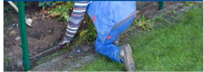
Den Zaunverlauf anhand einer Grundstücksskizze planen und die Flucht der Zaunanlage mittels einer Maurerschnur an zwei Punkten ausrichten. Nachdem Sie die erste Pfostenposition festgelegt haben, ergeben sich die weiteren Pfostenstandorte durch die Länge des Zaunelements. (s. Tabelle)
