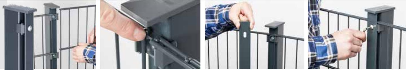
Die Zaunelemente werden auf die Befestigungspunkte gelegt. Darauf ist zu achten, dass die Matte sicher mittig auf dem Befestigungspunkt liegt. Danach wird die Abdeckleiste angebracht. Zunächst alle Schrauben handfest anziehen,
