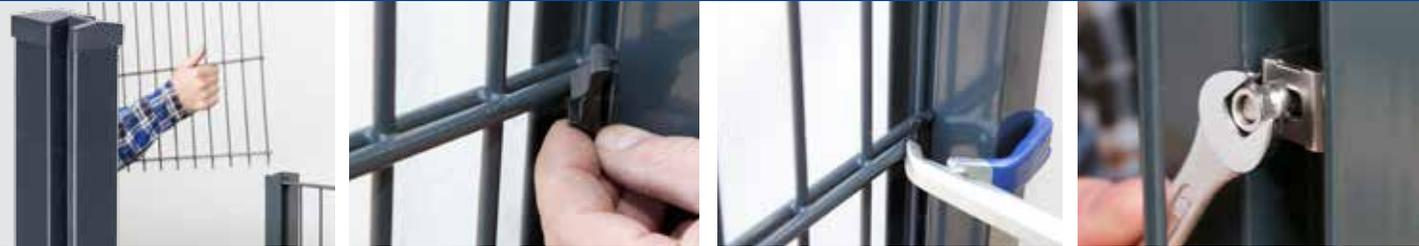
Die Zaunelemente werden von oben in den Profilrohrpfosten eingesetzt. Bei hohen Zäunen können die Pfosten schräg gestellt werden, um seitliches Einsetzen zu ermöglichen. Mit der HP-Zange, die um den Pfosten fasst,
